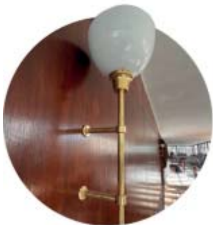
DETALLES DE REACONDICIONAMIENTO EN LA CASA PRINCIPAL. Realización de réplicas para la reposición de luminarias en el mobiliario central. / Limpieza de fachada y reacondicionamiento de herrrería y elementos carpintería y herrajes.
